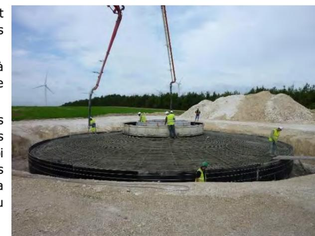
Figure 17. Construction d'une fondation
